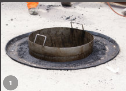
Niveau-Einbau mit Gussasphalt
