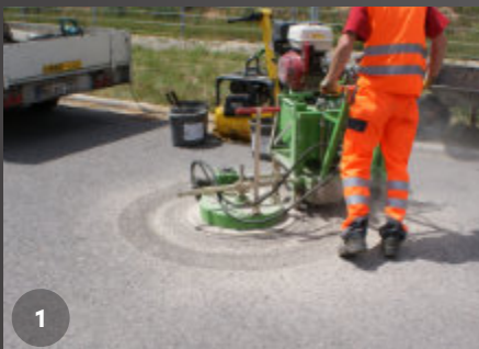
Niveau-Einbau inkl. Fräsbahn
