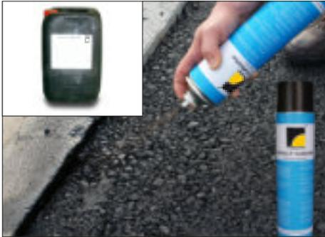
HEVOLIT®-Haftkleber wird für das Ansprühen der Unterlage zur Herstellung eines kraftschlüssigen Verbundes zwischen Asphaltsschichten eingesetzt. Die Verarbeitungshinweise können Sie unserem Technischen Merkblatt entnehmen!
